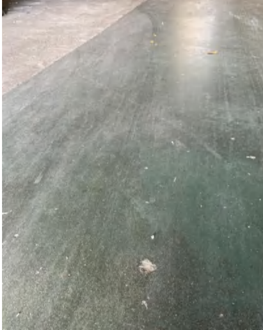
图 3-2 厂区地面硬化照
